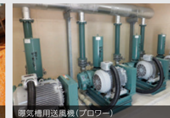
曝気槽用送風機 (ブロー)
