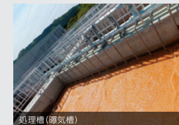
曝気槽 (曝気槽)
